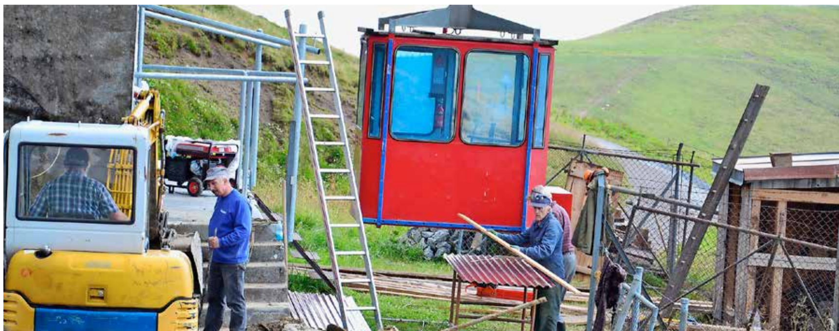
Es geht aufwärts – auch dank vieler fleissiger Helfer: Schon im vergangenen Jahr haben viele Freiwillige über 1850 Stunden an der Erneuerung der Seilbahn Palfries gearbeitet, wie hier bei der Bergstation.
